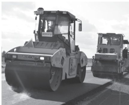
Асфальтоукладчики «Свердловскавтодора» обеспечивают ровное и равномерное покрытие дороги.
