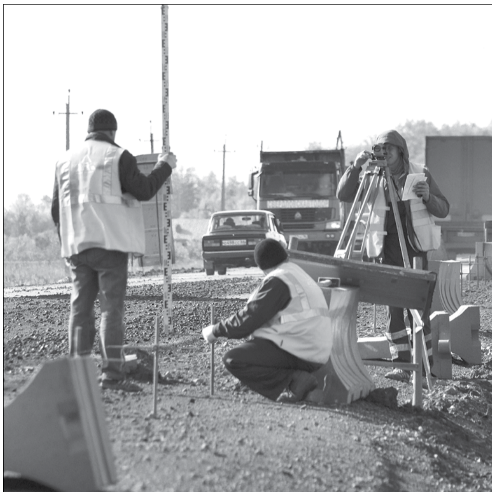
Рабочие с помощью съёмки нивелиром определяют отметки для укладки асфальтового покрытия.
