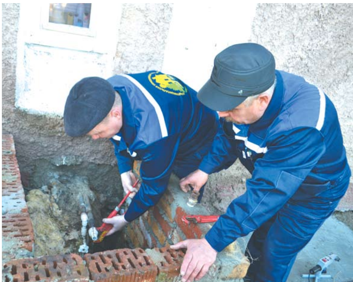
Подготовка к отопительному сезону в МУК «Уютный город» продолжается. Так, слесари Игорь Старков (слева) и Юрий Чапайкин меняют участок трубы горячего водоснабжения и запорную арматуру на вводе в дом № 7 на ул. Спортивной.
