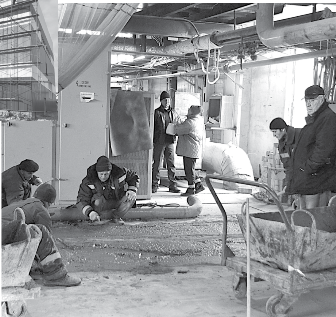
Вместо демонтированных котлов в бывшей котельной БФЗ будут установлены газогенераторные машины по производству электрической и тепловой энергии. Сегодня ведутся работы по устройству фундаментов для этих машин.
