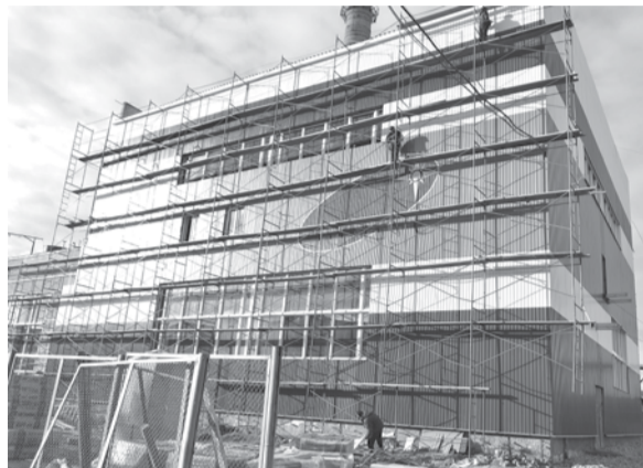
Для сокращения потерь тепла на собственном потреблении ОАО «БГК» производит ремонт здания котельной.
