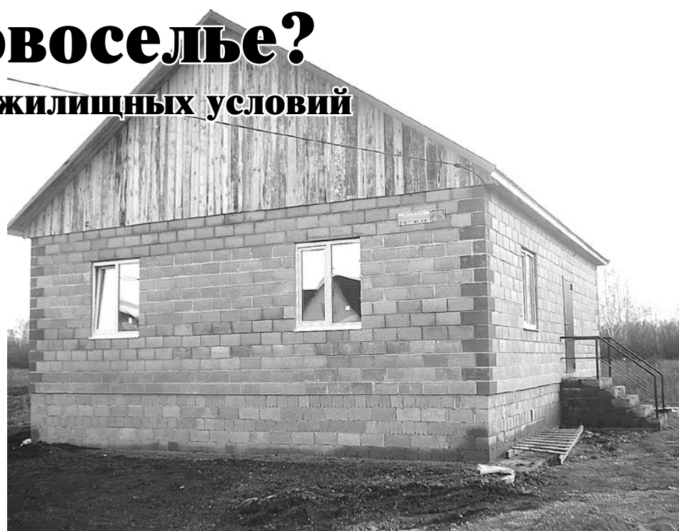
В новом доме многодетной семьи Татьяны (г. Богданович) проведено отопление, электричество, есть горячая и холодная вода. Осталось выполнить отделочные работы и можно будет справлять новоселье.
