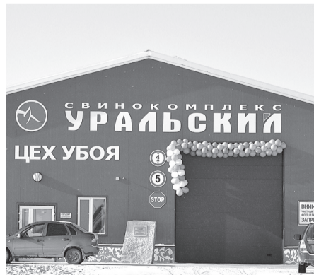
Строительство нового цеха, который позволит свинокомплексу осуществлять мясопереработку в рамках замкнутого цикла, велось около года.
