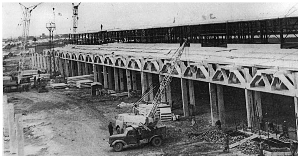
1970 год. Идет монтаж главного корпуса Богдановичского фарфорового завода. В 2009 году БФЗ был остановлен.
