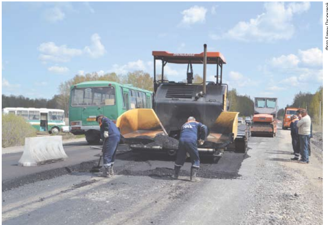
Сухоложское ДРСУ в рекомендациях не нуждается – здесь трудится опытный коллектив. Именно поэтому ему доверен ремонт федеральной трассы от п. Восток до 104 км. На снимке: идет выравнивание дорожного полотна.
