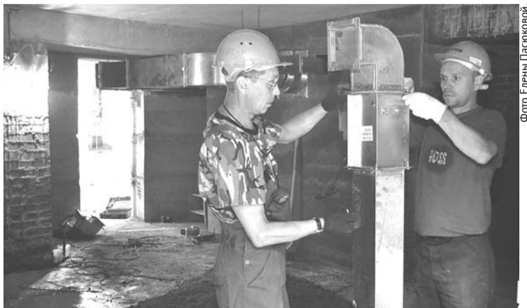
В скором будущем горожане смогут плавать в бассейне, но пока здесь полным ходом идет строительство. Монтажники Денис Васильев и Александр Овчинников ведут монтаж канального вентилятора.
