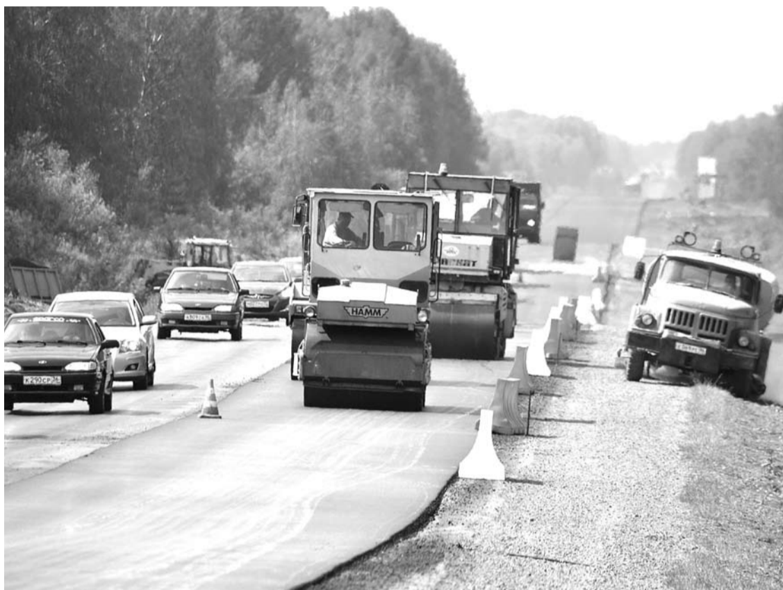
На ремонте трассы Богданович-Камышлов задействованы коллективы всех трех участков Сухоложского ДРСУ. На снимке: укатку асфальта осуществляют работники Богдановичского участка № 2.
