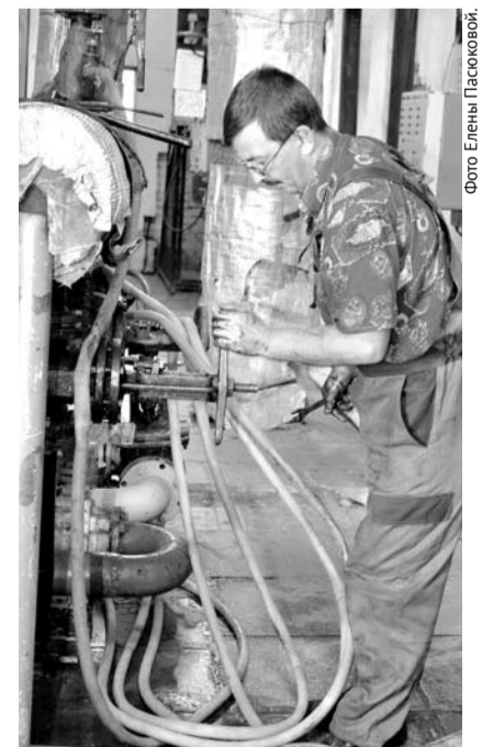
Работы в котельной № 5 подходят к завершению. На снимке: слесарь Алексей Прожерин проводит ревизию арматуры линии подпитки внутренних сетей.
