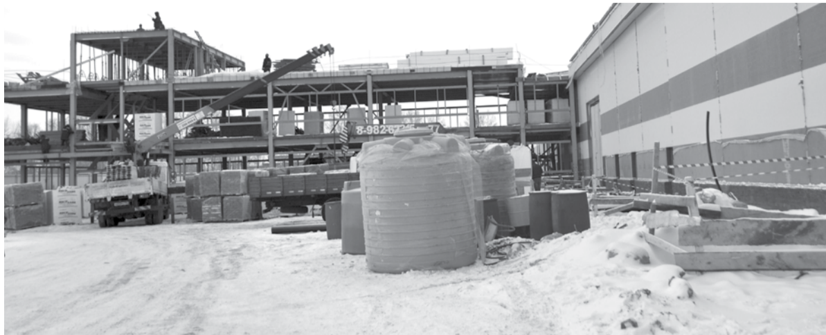
В Богдановиче идет строительство нового современного предприятия по переработке мяса.
