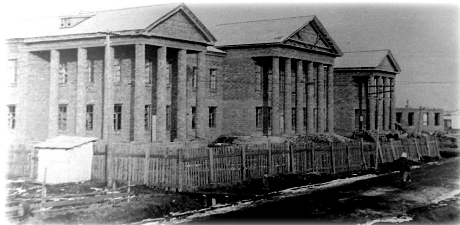
В послевоенном 1947 году было построено здание политехникума.
