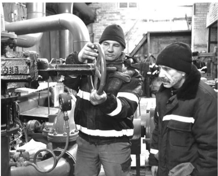
На узле подмеса теплоноситель доводят до нужной температуры. Регулировку давления в сети производят работники МУП «БТС» Николай Тимбурский и Алексей Хорьков.
