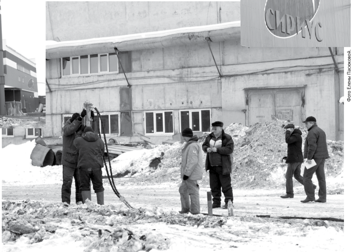
Работники ООО «Камтэк» строят ограждение для ТЭЦ, которая будет производить электроэнергию и тепло для северной части города.
