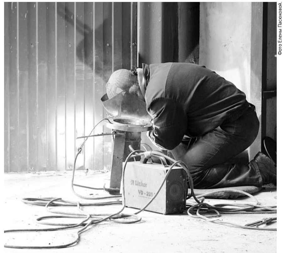
На строящейся теплоэлектростанции идут работы по установке фильтра для газогенераторов.
