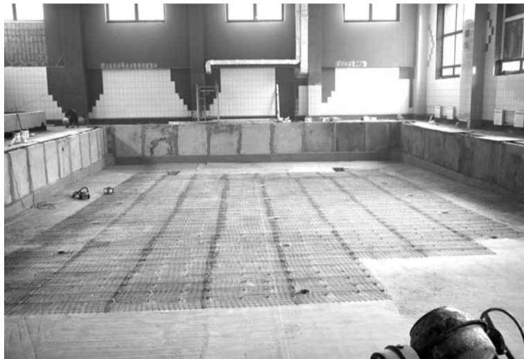
В Богдановиче в строящемся бассейне вовсю идут работы.
