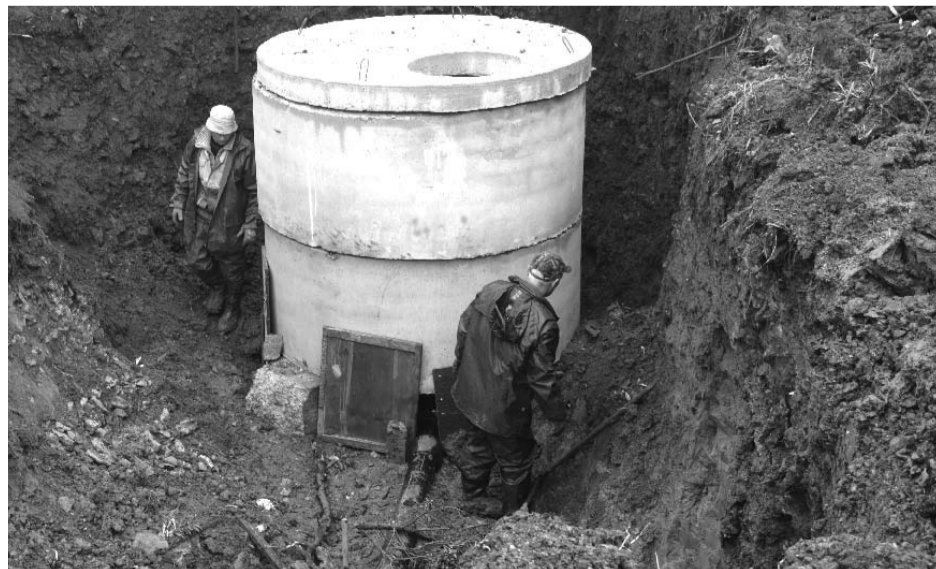
Работники МУП «Тепловодоканал» завершают монтаж распределительного колодца на улице Крылова.
