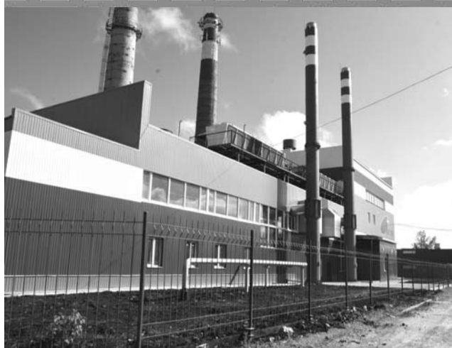
Пущена в эксплуатацию мини-ТЭС ОАО «Богдановичская генерирующая компания», подающая электроэнергию и тепло в северную часть города.
