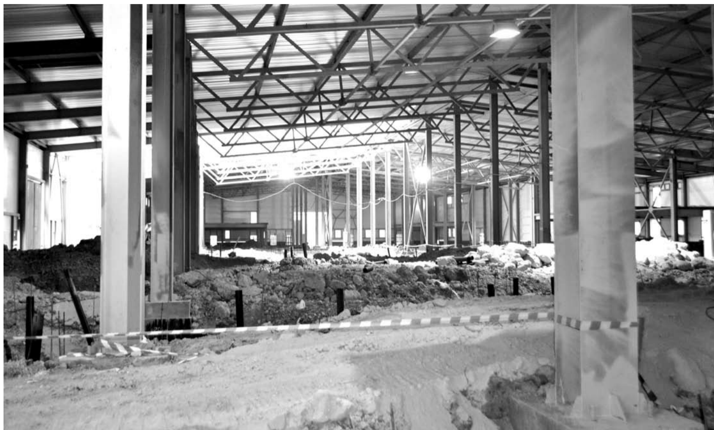
Строительство мясокомбината идет полным ходом, его пуск ожидается во втором квартале 2015 года.
