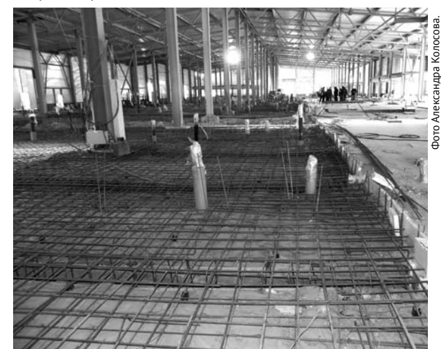
В Богдановиче полным ходом идет строительство нового мясокомбината.
