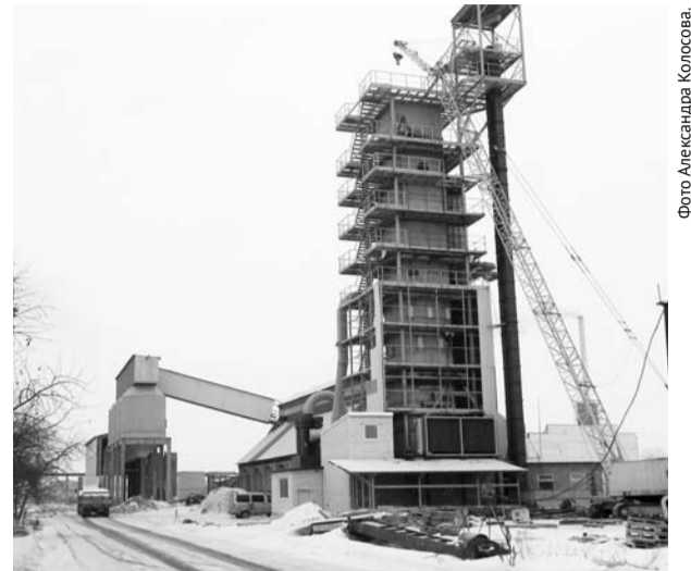
Строительство завода по производству извести.
