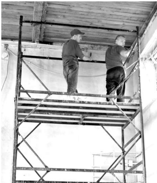
Ремонт спортзала в Тыгишской школе.
