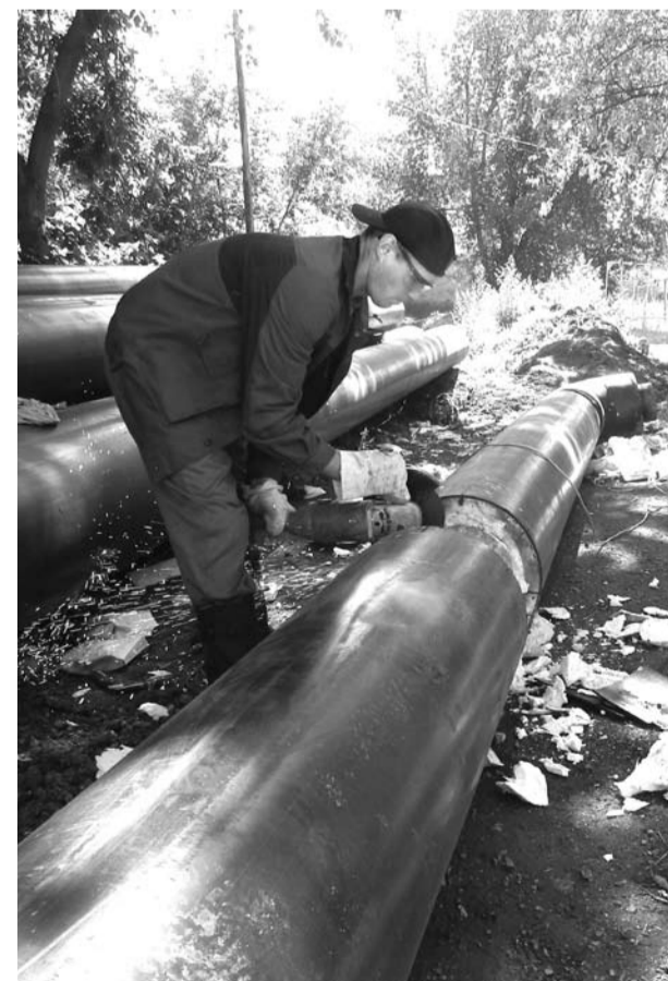
Ремонт тепловой магистрали.
