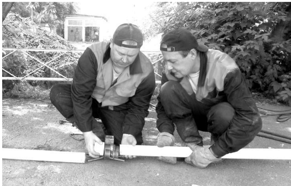
Работники ОАО «БГК» Иван Лобанов и Андрей Ларионов производят сварку трубы ГВС для трассы, ведущей к детсаду №13.
