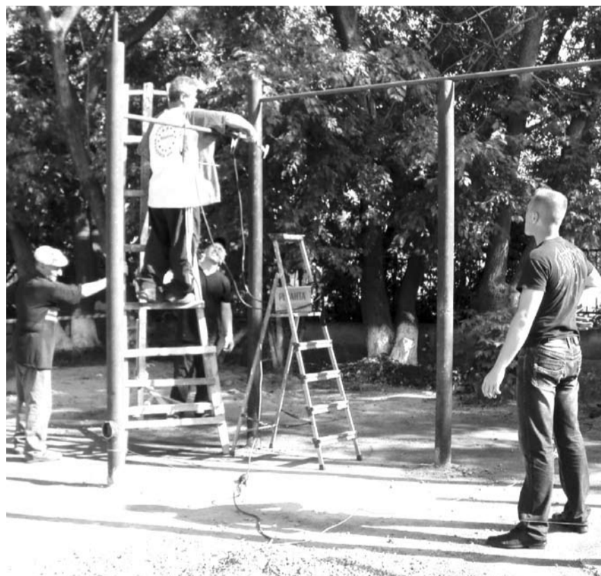
Около ДК в с. Байны полным ходом идет строительство детской спортивной площадки.
