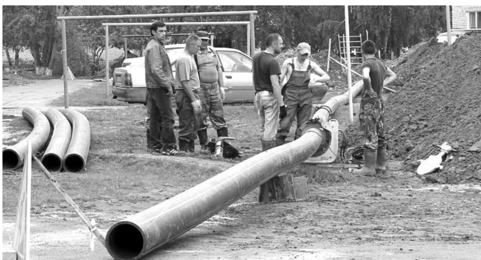
Работники МУП «Тепловодоканал» монтируют водопровод между общежитиями №39/2 и №41 на улице Степана Разина.
