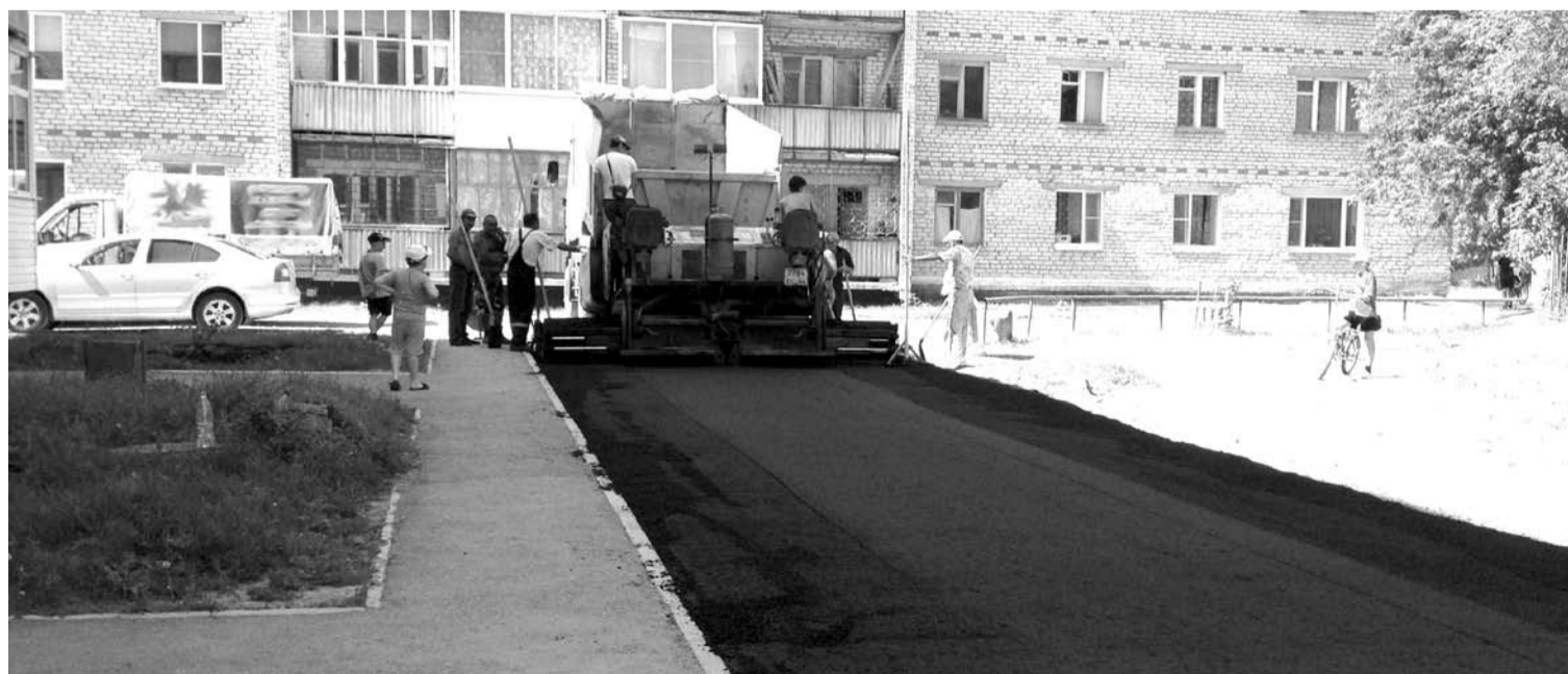
Подрядная организация «ИП Авакян Д.Е.» завершает строительство дворового проезда на улице Рокицанской.
