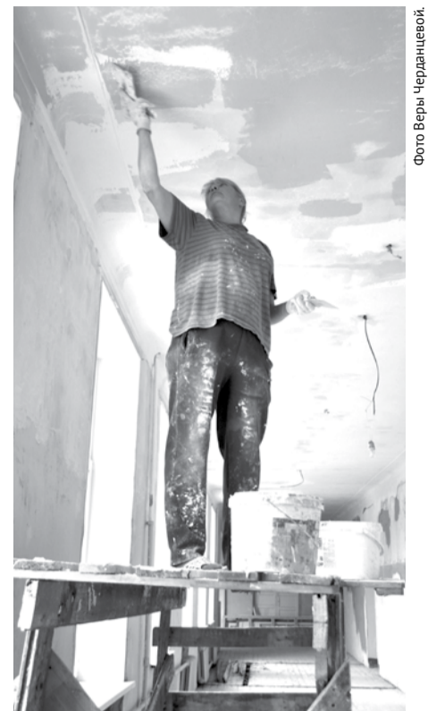
Штукатур-маляр Ольга Петрова заканчивает ремонт потолка.
