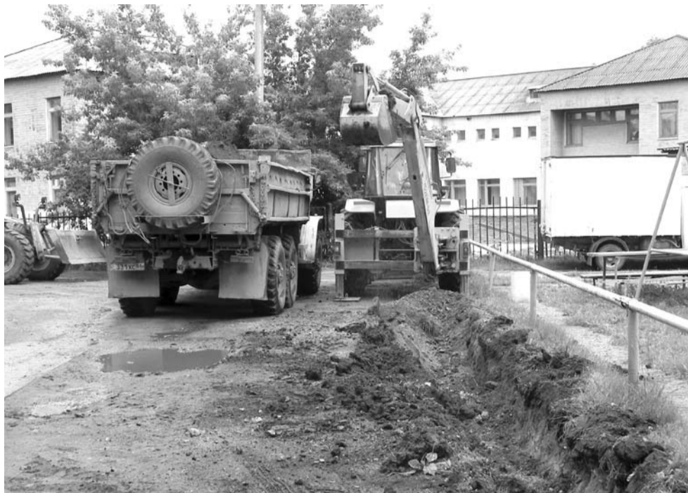
Строительство автостоянки началось с выкапывания дренажной выемки.
