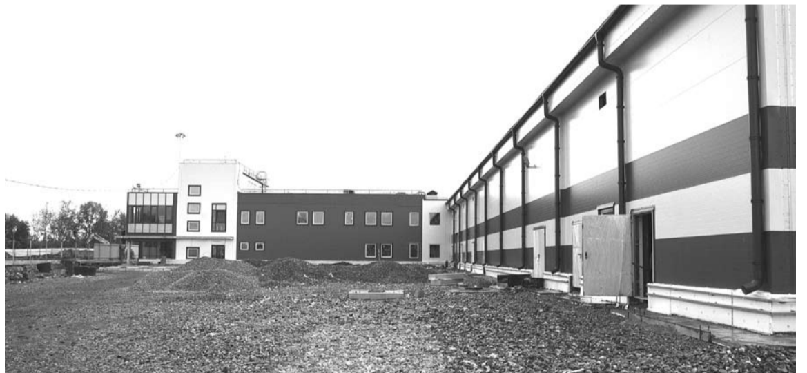
Строительные работы на мясокомбинате подходят к концу.
