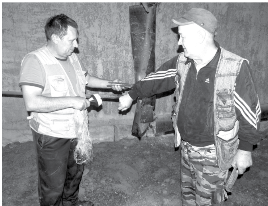
Замену спускных клапанов центрального отопления проводят работники МУП «Городская УК» Николай Васенёв и Михаил Сунцов.
