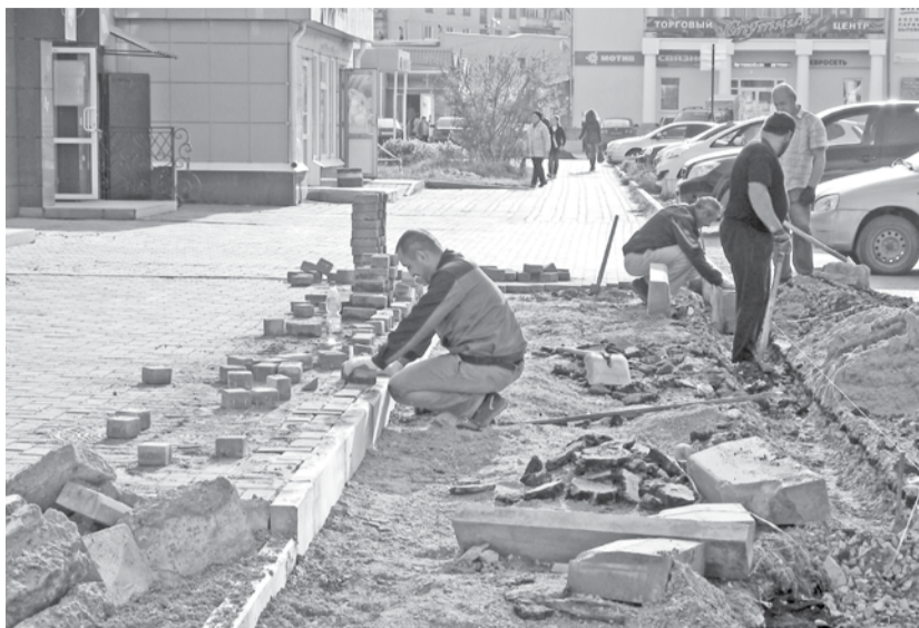
Работники ИП Авакян Д.Е. ремонтируют тротуар на улице Советской.
