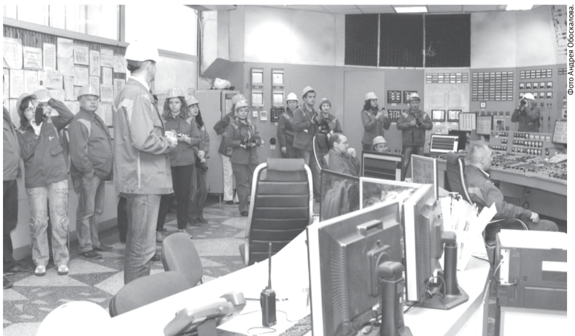
Мы в самом сердце Рефтинской ГРЭС, с этого пульта идет управление всеми процессами электростанции.
