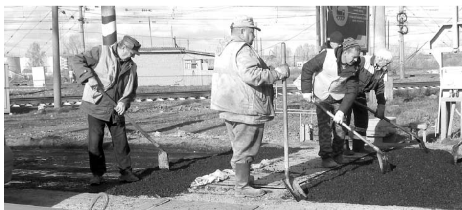
Работники Сухоложского ДРСУ ремонтируют полотно дороги на переезде.
