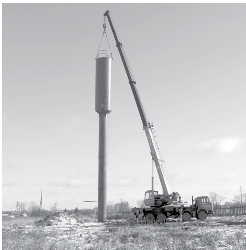
В Байнах была смонтирована и установлена новая водонапорная башня.
