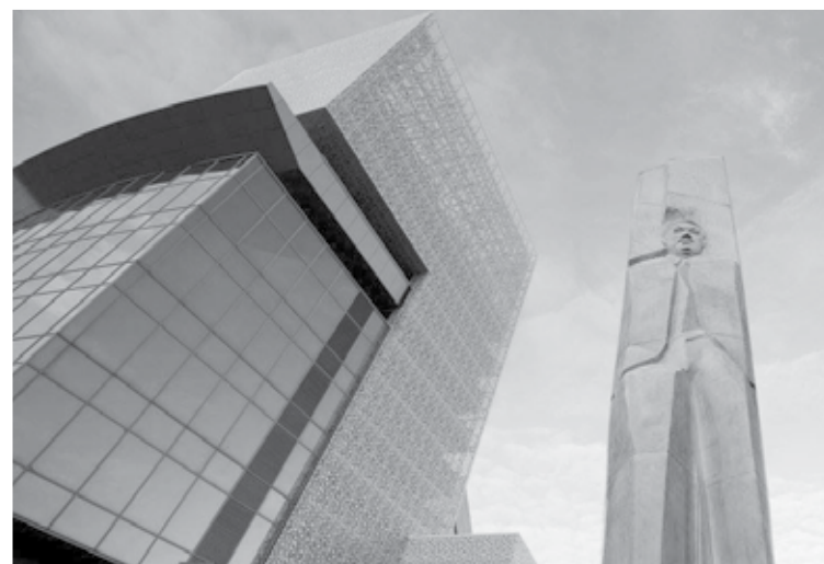
Работы по созданию центра велись с 2011 года. Сейчас это пятиэтажное здание многофункциональной направленности.
