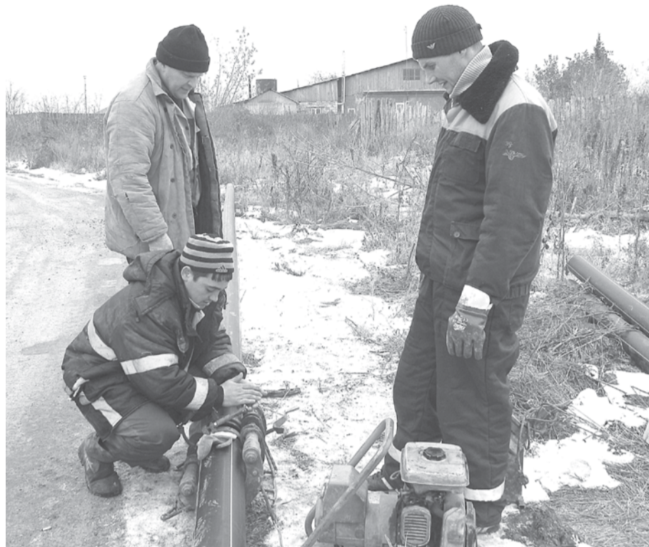
Благодаря проведенному ремонту водопроводных сетей улучшилось водоснабжение жилого сектора ГО Богданович.
