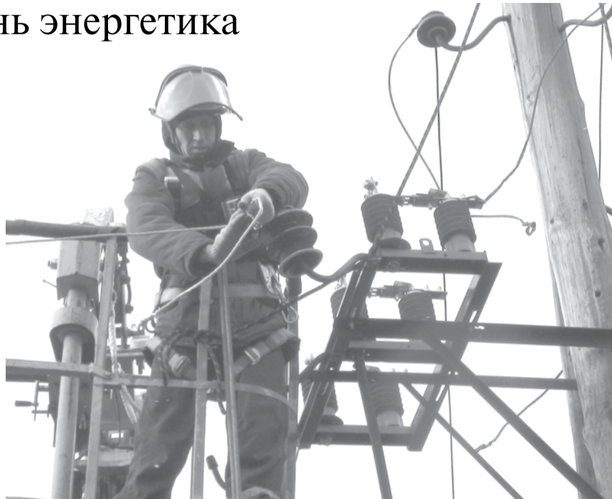
Работник ВЭС Александр Головин производит замену выносного разъединителя в деревне Кашина.
