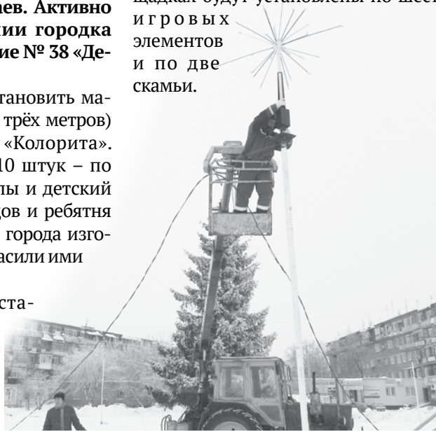
Работники ООО «ПМК-2» устанавливают «фейерверки» возле ёлки.
