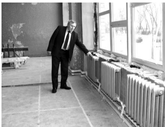
Ремонт в спортзале Гарашкинской школы.
