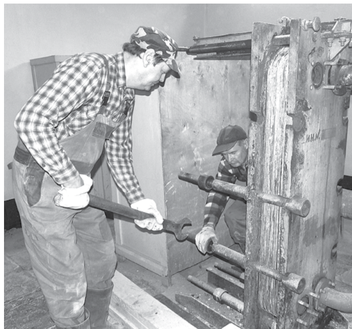
В теплом пункте №3 ведется демонтаж старого оборудования.
