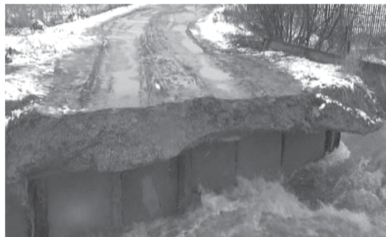
Струя воды с полей размыва насыпь у моста в деревне Ляпустина (фото представлено телеканалом «ТВ-Богданович»).
