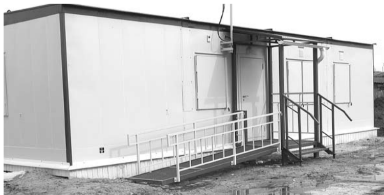
В с. Ильинском построен новый блочный ФАП.
