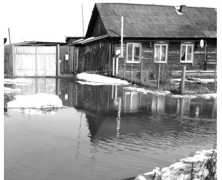
Каждую весну дом №15 на улице Рабочей в с. Ильинском заливают паводковые воды.
