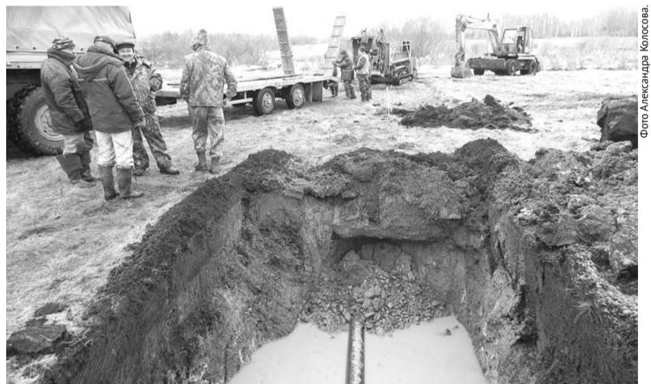
Магистральный газопровод строится бестраншейным методом - путём проколов.
