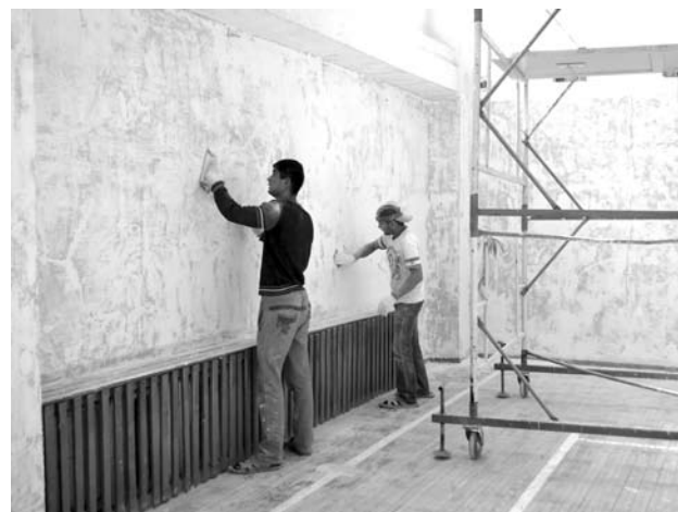
Ремонт спортзала Грязновской школы.
