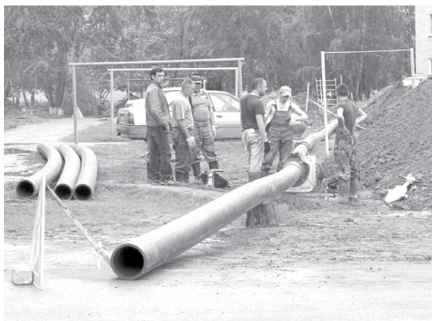
Замена трубопровода в северном микрорайоне.
