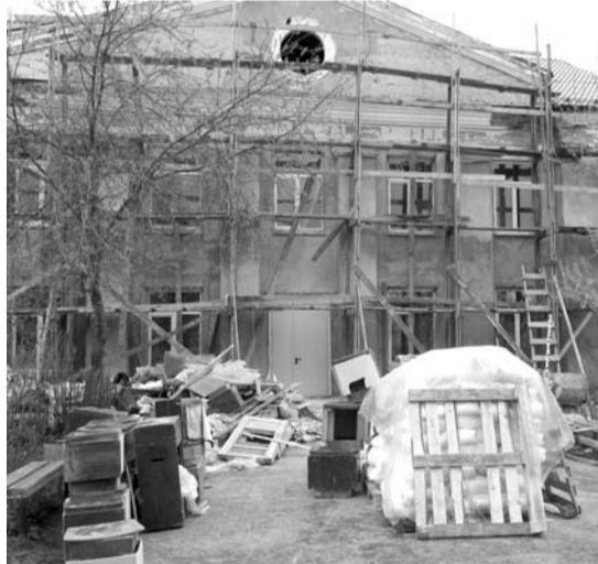
Тыгишский ДК ремонтируется сегодня.
