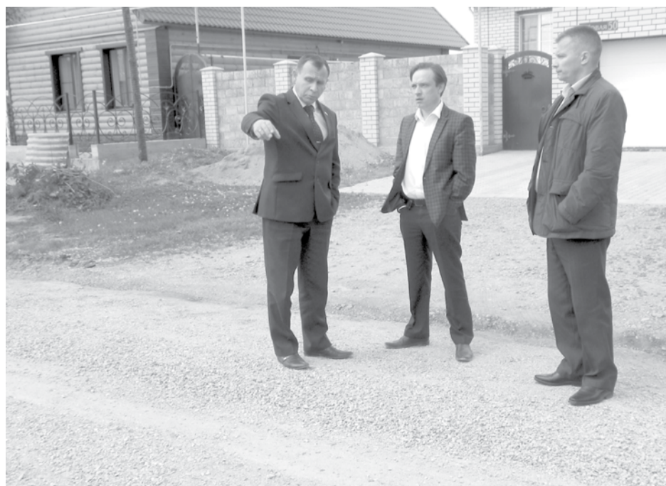
Виталий Топорков, Владимир Москвин и Андрей Стюц обсуждают качество ремонта дороги на улице Новой.
