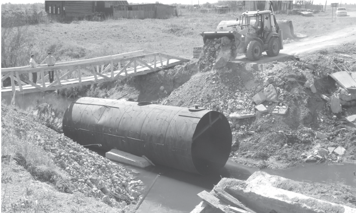
Работники МУП «Благоустройство» восстанавливают мост через Малую Калиновку в Суворах.
