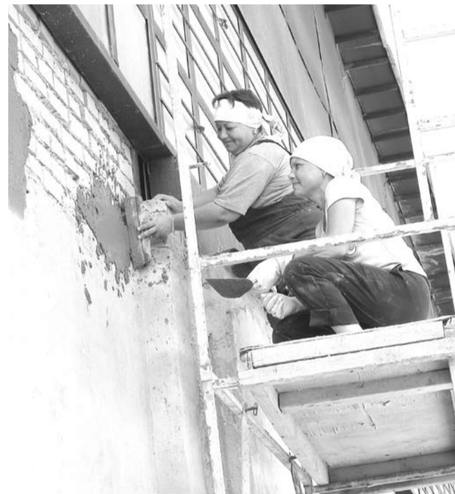
Штукатуры РСЦ Ирина Контеева и Людмила Ермолина ремонтируют стену помещения, где расположен участок по изготовлению поддонов.
