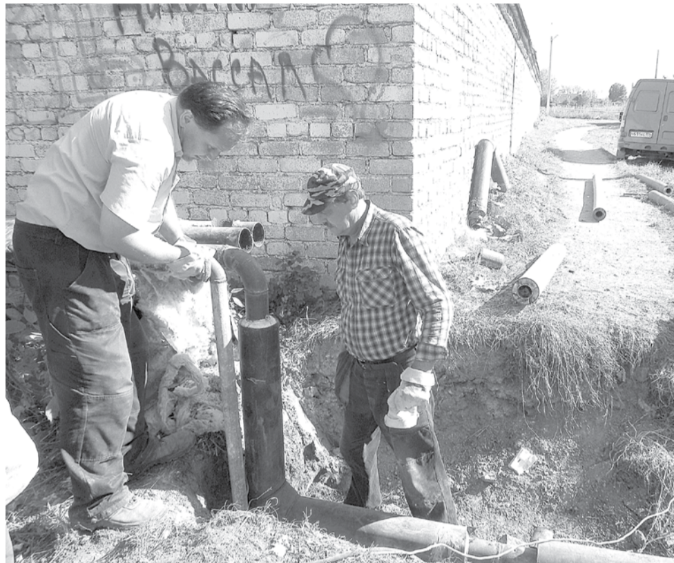
Работники ОАО «БГК» заглубляют теплотрассу возле дача №27.
