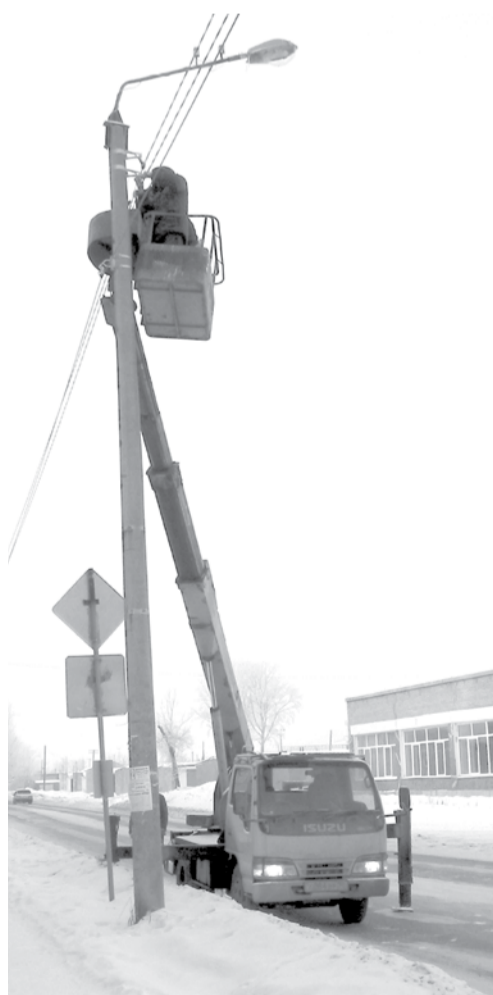
Идет замена проводов на улице Первомайской.
