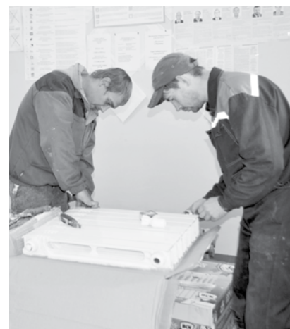
Бригада Сергея Золотова выполняет сборку и установку радиаторов отопления.
