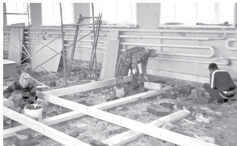
В настоящее время полным ходом идут работы по замене пола в спортзале школы.
