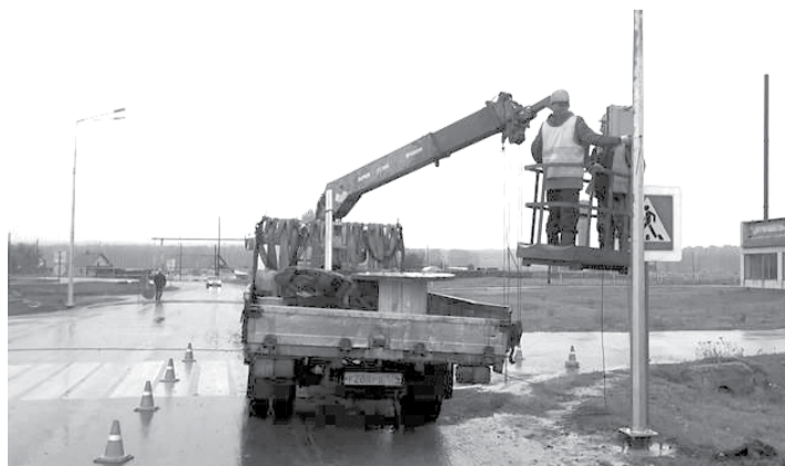
Работники подрядной региональной организации ООО «ШВАБЕ-Екатеринбург» устанавливают освещение пешеходного перехода.
