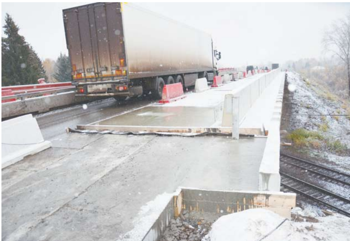
Эта полоса уже готова к асфальтированию.
