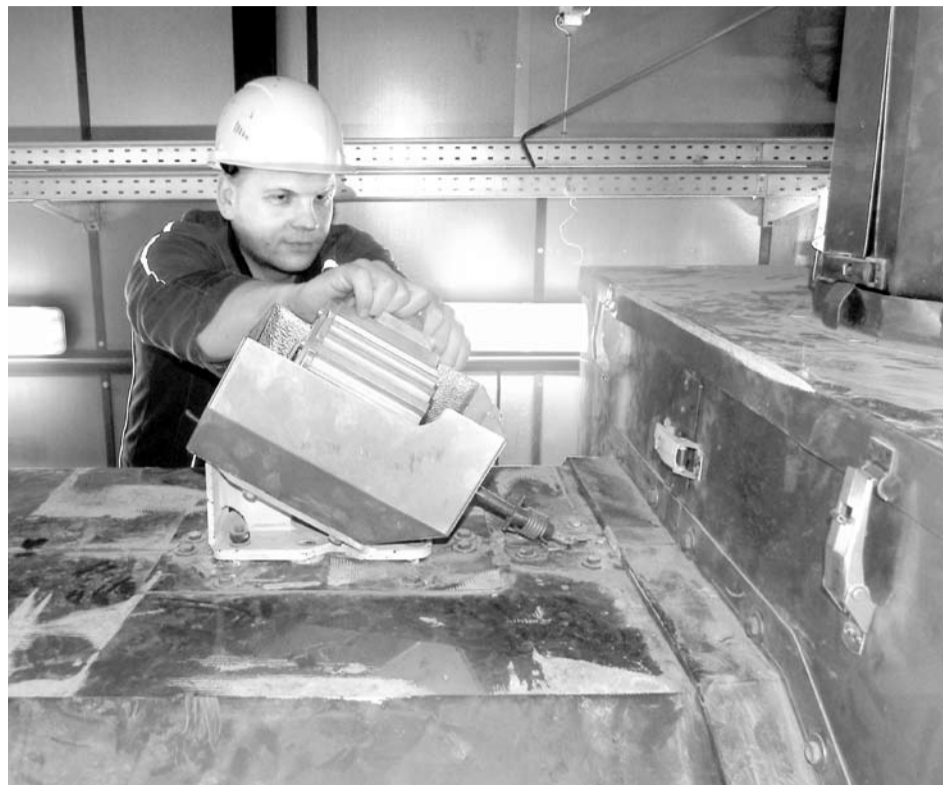
Дмитрий Родин, механик «Мотоверк-СГУ», производит обслуживание турбокомпрессора газопоршневого агрегата.
