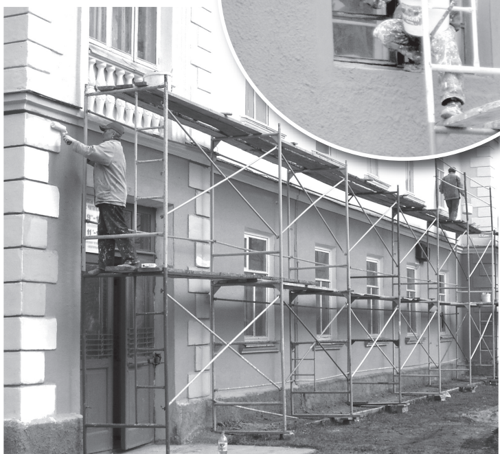
Работники ООО «Жильё» ремонтируют фасады домов на улицах Мира и Ленина.
