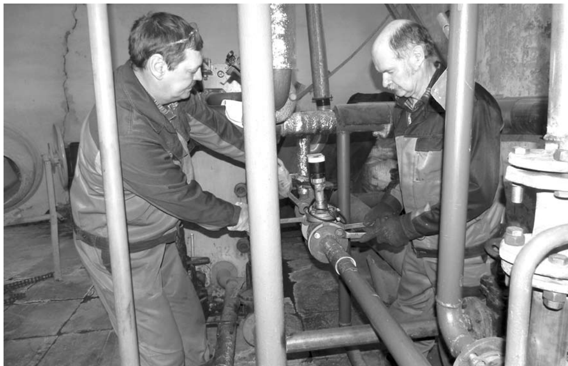
Монтаж системы горячего водоснабжения в теплопункте №3 осуществляют работники ОАО «БГК» Сергей Валов и Василий Коробицын.
